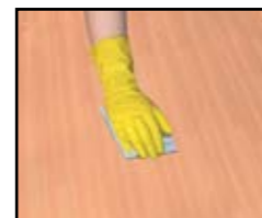
Свежий, невысохший клей, оставшийся на поверхности деревянного покрытия, а также на инструменте и руках, необходимо удалить с помощью чистой ткани или специальных салфеток Sika®TopClean-T.
