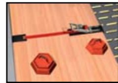
Свежий, невысохший клей, оставшийся на поверхности деревянного покрытия, а также на инструменте и руках, необходимо удалить с помощью чистой ткани или специальных салфеток Sika®TopClean-T.
